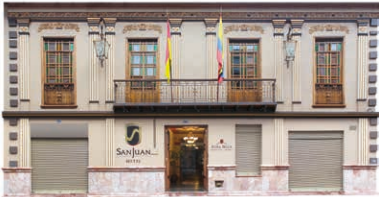
Figura 9. Arquitectura Neoclásica en Cuenca, General Torres 9-49 (Fuente: Ochoa, Paúl, et al. (2013). “El Patrimonio Edificado de Cuenca”)
