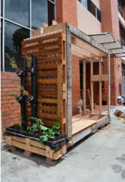
Entrega final Minga LAB 2.0, trabajo conjunto de alumnos de 7mo y 1er Ciclo PROTOTIPO EN BASE A ANILLOS DE MADERA, ESCALA 1:1 Proyecto ganador
