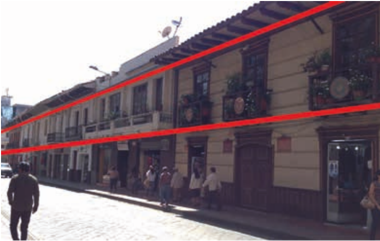
Figura 7: Pauta con línea horizontal que organiza la composición de las edificaciones. (Fuente: autores)
