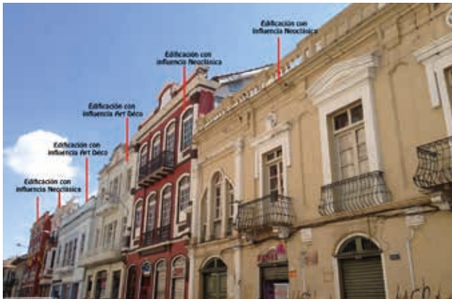
Figura 5: Fachadas de la calle Benigno Malo, que muestran distintos estilos arquitectónicos. (Fuente: autores)
